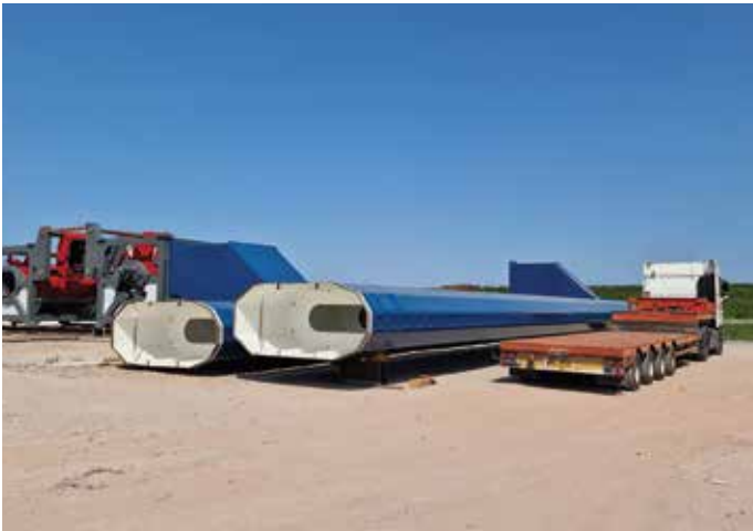
Hoofdliggerdelen, schouder aan schouder (gestraald, meervoudig verfsysteem).
